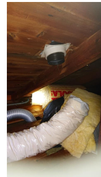
På kaldtloft er slange for avtrekk seget ned fra lufterhette og bør monteres før bruk av ventilator.
