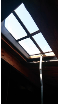
Støpejernluke på kaldtloft fra byggeår.
